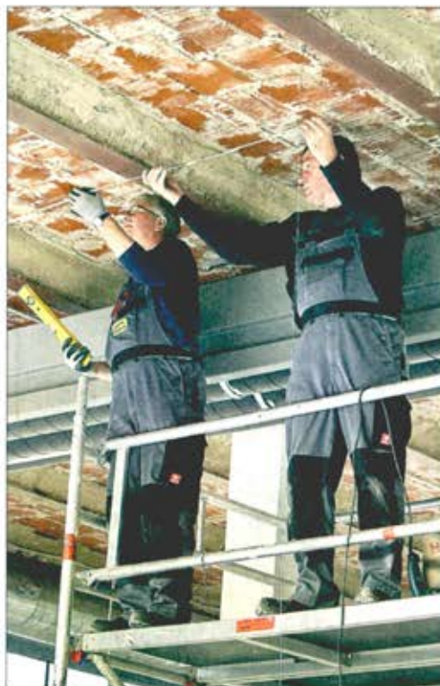
Bernd Heiderich (links) und Peter Assenmacher von der Firma Elektro Bechmann verlegen im ersten Stock neue Leitungen für die Beleuchtung. Rechts ein Blick in die Ausstellung. Der Kassenbereich, derzeit noch fast mitten in der Ausstellung, wird im März verlegt. Fotos: Klaus Wuggazer, Sascha Willms
